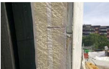
Realizzazione di angoli nel sistema per cappotto termico Betontherm Strong
